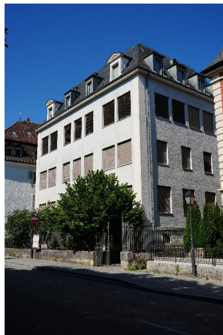
BÂTIMENT DU CONTRÔLE – module 95
