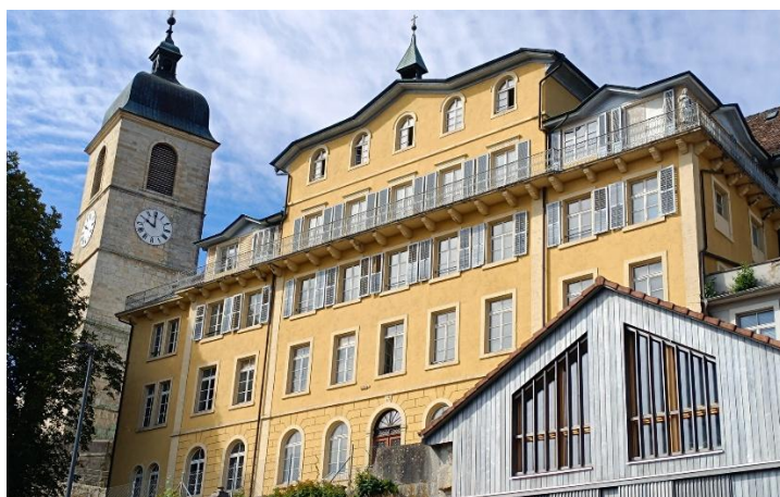
BÂTIMENT DES URSULINES – module 93
